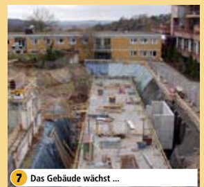
7 Das Gebäude wächst ...
