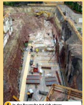
4 In der Baugrube tut sich etwas
