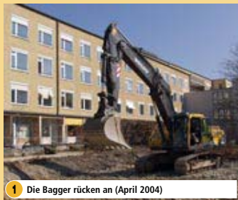
1 Die Bagger rücken an (April 2004)
