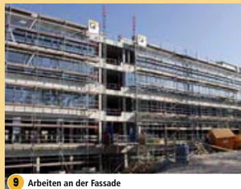
9 Arbeiten an der Fassade
