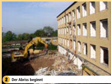
2 Der Abriss beginnt
