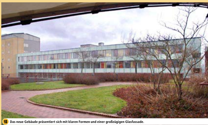
15 Das neue Gebäude präsentiert sich mit klaren Formen und einer großzügigen Glasfassade.
