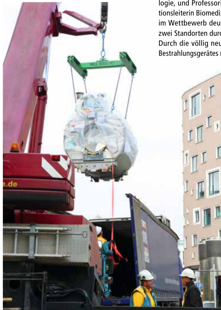
Am 8. September 2017 schwebte der Magnet, das tonnenschwere Herzstück des neuen Gerätes, per Kran ins Gebäude ein.
