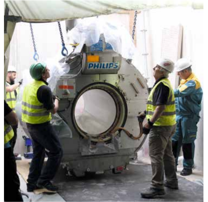
Präzisionsarbeit war angesagt: Über einen eigens für das Gerät errichteten Schacht wurden die fünf Tonnen zentimetergenau durch die Öffnung in das Forschungszentrum für Hochpräzisionsbestrahlung gehievt.
