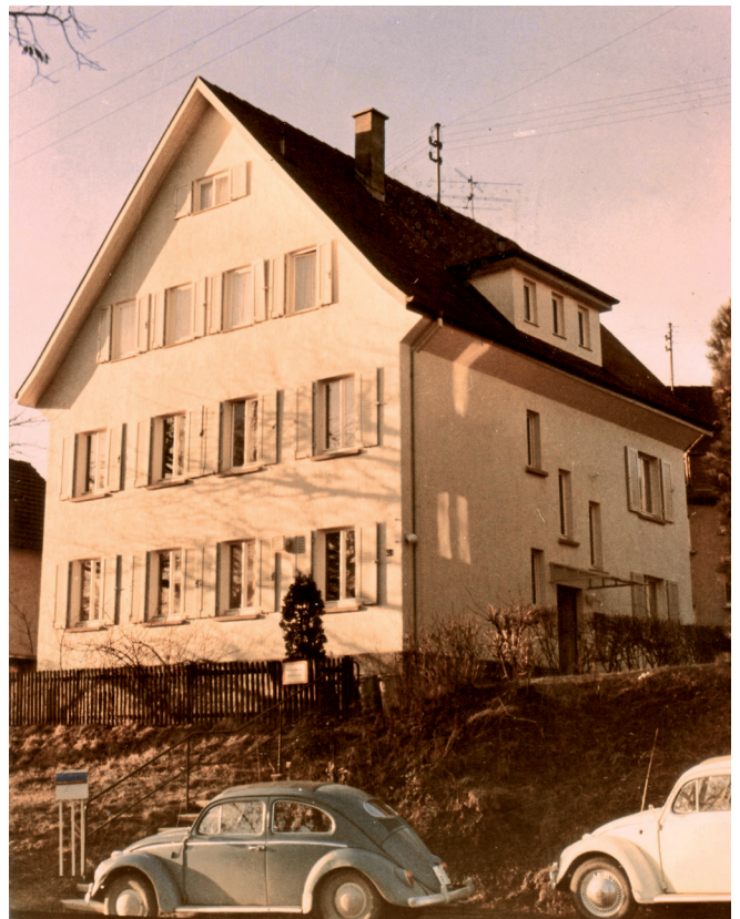
Abb. 6: Institutsgebäude in der Frondsbergstraße 31 in Tübingen, Heimstätte des Instituts für Arbeitsmedizin 1965–1977 [6]
